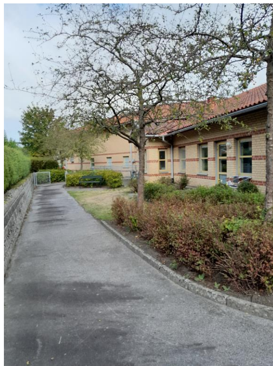
Del av byggnad mot söder.
