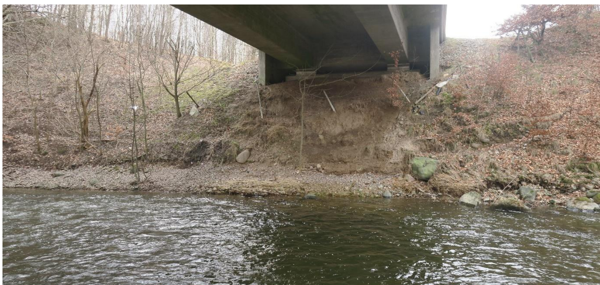
Figur 3.5.3-3 Foto under väg 13, mot södra landfästet.
