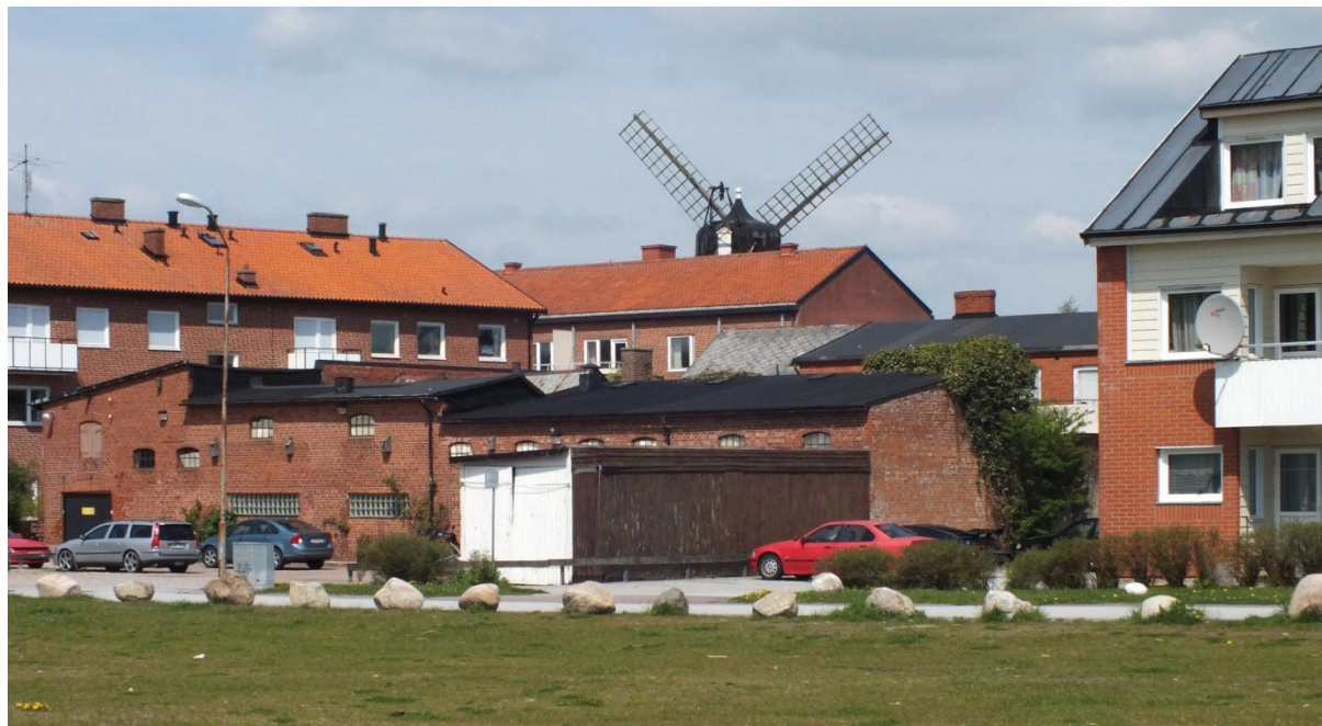
Kvarteret mellan Västergatan och Hotellgatan där det finns många bevarade äldre lokaler på gården.
