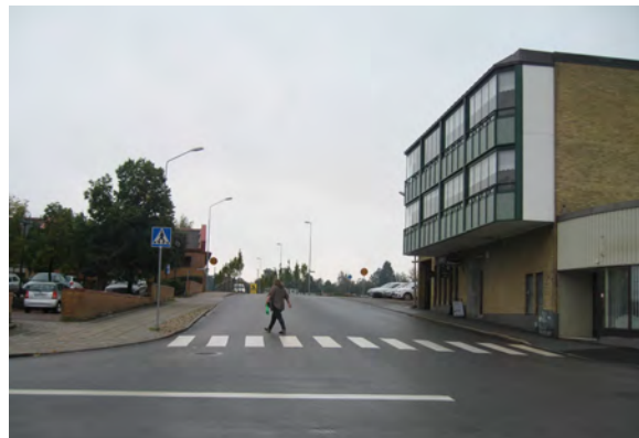
Figur 4-5. Gångpassage med målad vägmarkering och vägmärke som upplyser fordonstrafiken om passagen och gällande reglering.
