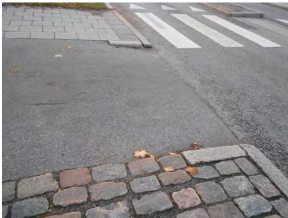
Figur 4-14. Exempel på en passage som är anpassad för personer med funktionsnedsättning.
