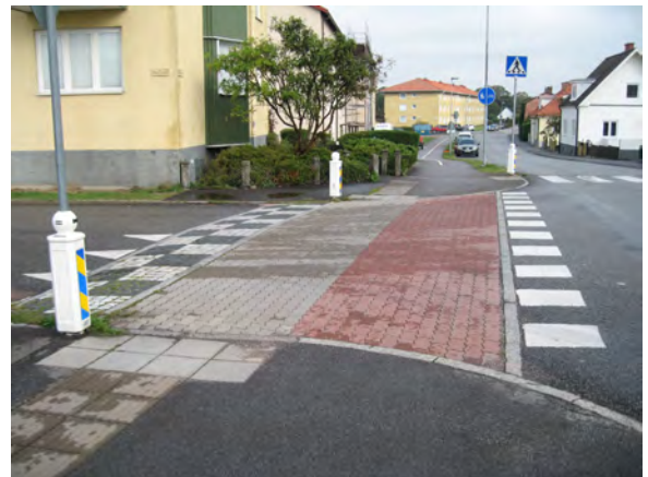
Figur 5-4. Passageutformning som är vanligt förekommande i Sjöbo. Gång- och cykeltrafiken är visuellt separerade från varandra med olika markbeläggning.
