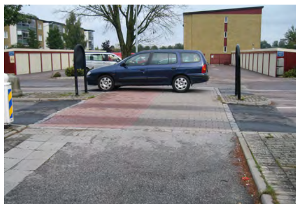
Figur 4-6. Hastighetsäkrad passage i form av platåupp med refug. Passagen är trafikseparerad mellan gång- och cykeltrafik samt försedd med taktila plattor.
