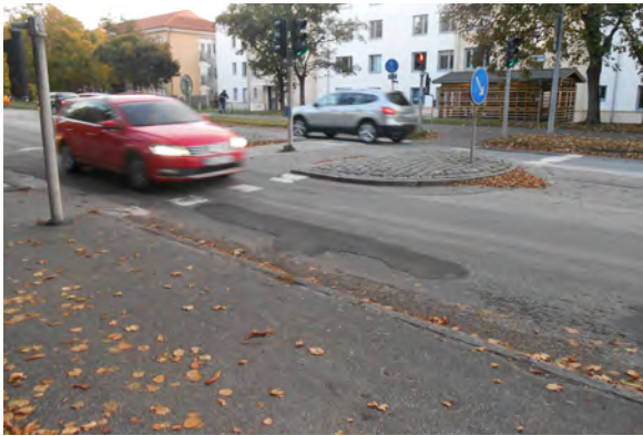
Figur 7-8. Exempel på refug i gata för att smälta av körbanans bredd och på så vis sänka hastigheten.
