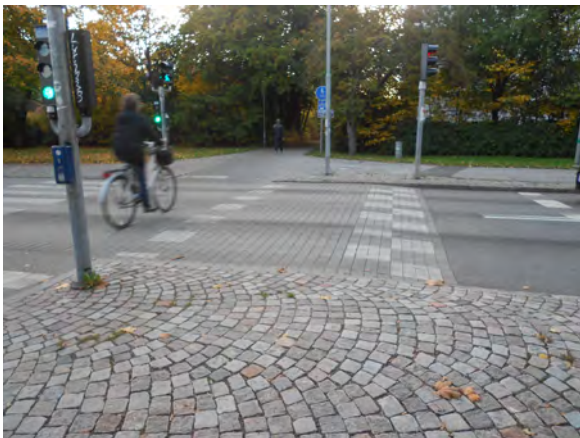
Figur 7-9. Exempel på gång- och cykelpassage som är hastighetssäkrat med platågupp i gatsten.
