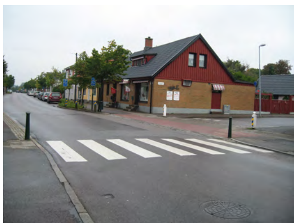
Figur 7-1. Gatukorsning i centrala Sjöbo med olika materialval samt rödmarkerad, upphöjd överfart för att tydliggöra korsningens funktion.
