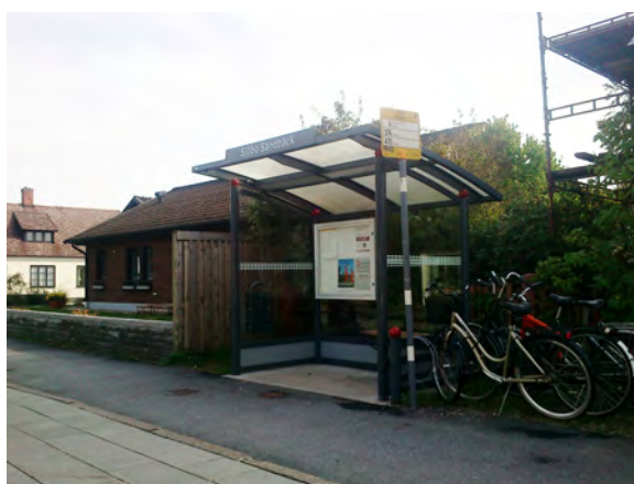
Figur 5-7. Cykelparkering vid Sjöbo Sandbäcks busshållplats. Cykelparkeringen saknar väderskydd.
