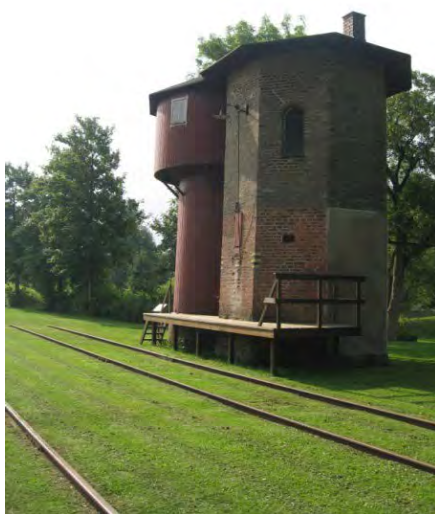
Figur 7-1. Pumphuset i Vollsjö.
