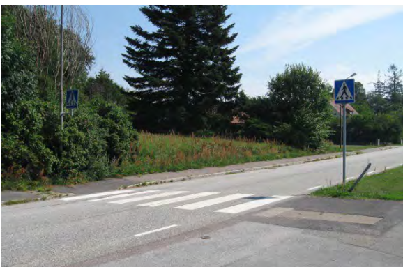
Figur 8-8. Målad gångpassage över Storgatan försedd med taktila plattor och trottoar nedsänkt till noll-nivå.
