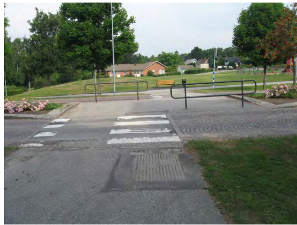
Figur 7-7. Gång- och cykelpassage med refug och gatsten. Passagen är tillgänglighetsanpassad.
