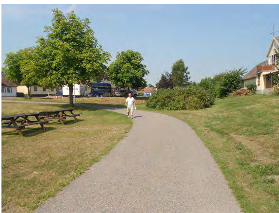
Figur 9-6. Gång- och cykelväg i Äsperöd som förbinder busshållplats med Snavavägen.
