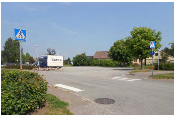
Figur 9-8. Målad gångpassage över Byavägen.
