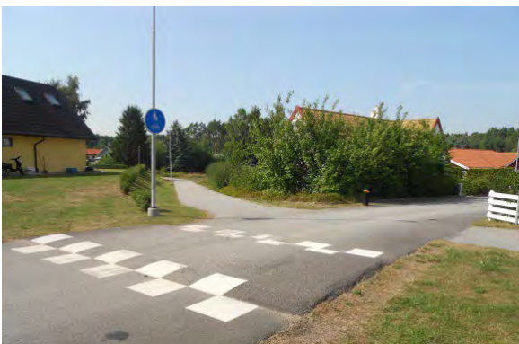
Figur 11-9. Gång- och cykelpassage med refug och gatsten. Passagen är tillgänglighetsanpassad.
