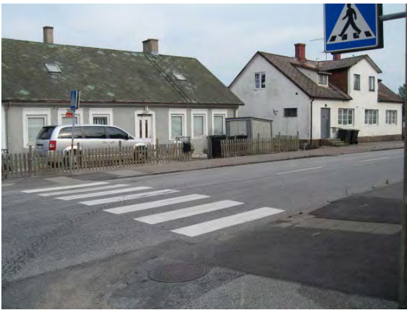
Figur 7-6. Målad gångpassage över Storgatan försedd med taktila plattor och trottoar nedsänkt till noll-nivå.
