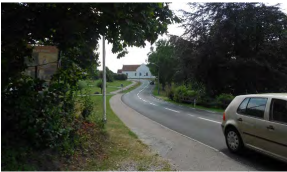
Figur 10-6. Trottoar på Sövdesborgvägen.
