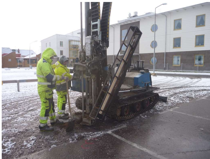
Figur 3. Provtagning med skruvborr monterad på bandvagn.
