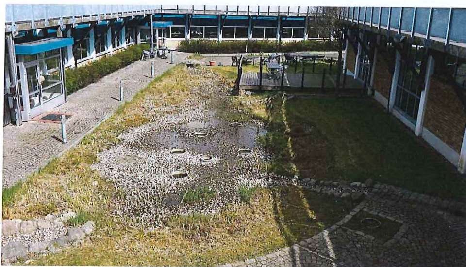
Figur 14. Dagvattendamm med anslutning av stuprör. (Ramböll)
