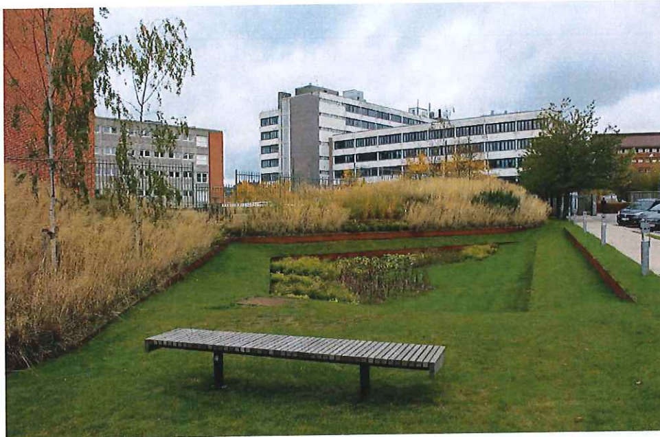
Figur 15. Födröjningsdamm i Lundbeck, Köpenhamn
