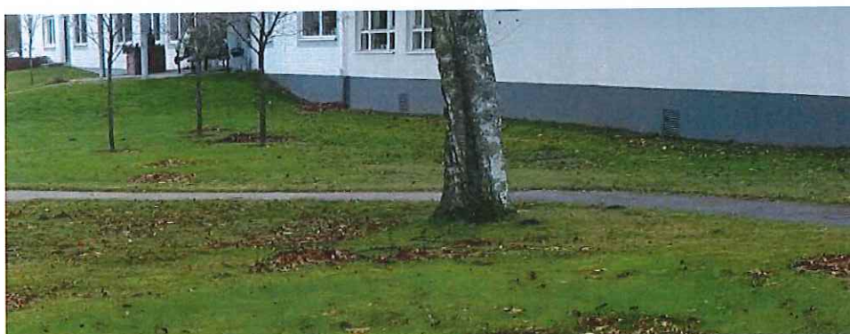
Figur 12. Bild på de ventiler som kan ta skada vid skyfall.
