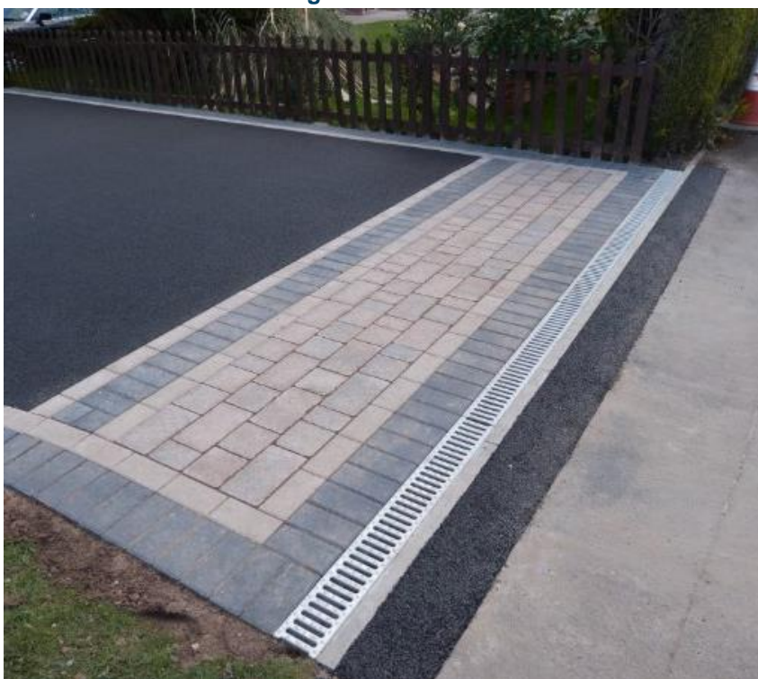
Figur 5-11 Avrinningen från uppfarten samlas i en ränna, motsvarande AcoDrain.
