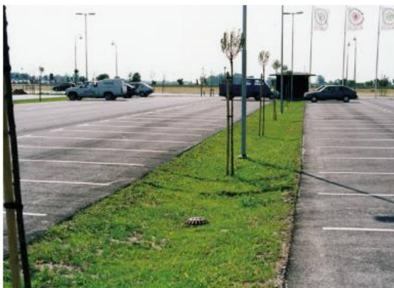
Figur 5-4 Infiltrationsstråk vid parkering i Malmö.
