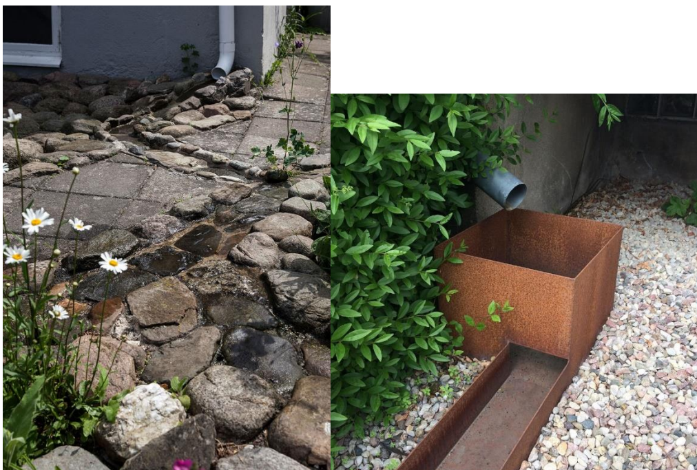
Figur 5-8 Exempel på gestaltning av stuprörsutkastare. Foto: VA-Syd.
