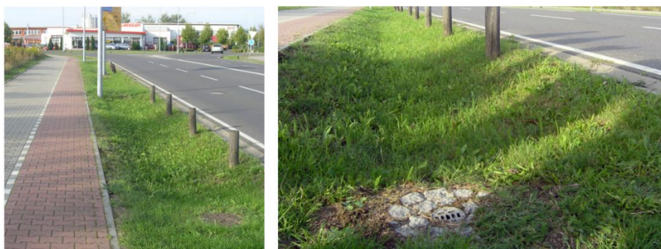
Figur 5-3 Ett infiltrationsstråk som tar emot dagvatten på bred front från vägbanan. I den högra bilden syns bräddbrunnen som är placerad några centimeter över diketets botten (SVOA, u.d.).
