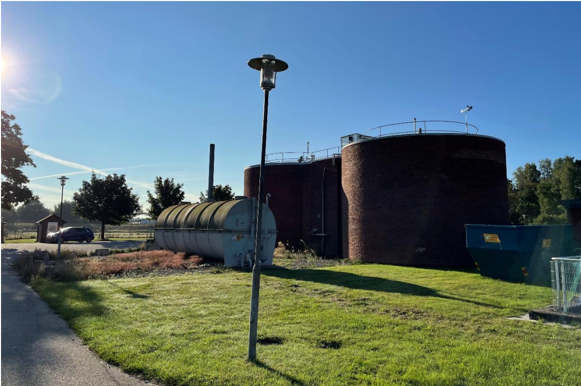
Gasklocka och rötkammare
