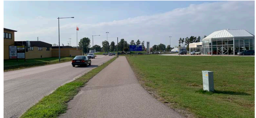
Figur 12 Sjöbo västs huvudentré är inte synliggjord. På sträcka vid planteringsgatan åtskiljs GC-banan från biltrafiken endast med en smal skiljeremsa. Särskild belysning för GC-banan saknas.
