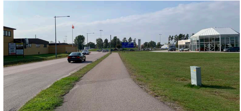
Figur 8 Sjöbo västs huvudentré är inte synliggjord. På sträcka vid planteringsgatan åtskiljs GC-banan från biltrafiken endast med en smal skiljeremsa. Särskild belysning för GC-banan saknas.
