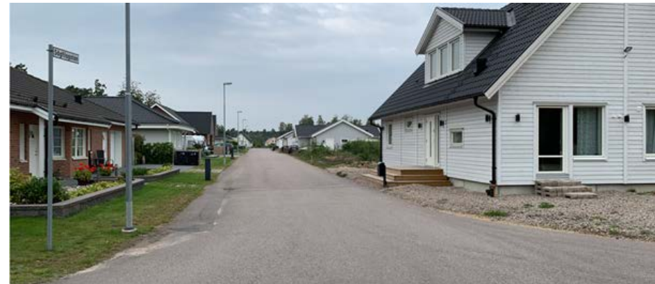
Figur 14 Trafik leds in från Nävervägen på villagatan Sågfilsgatan, där det inte finns gång- eller cykelbana för oskyddade trafikanter.
