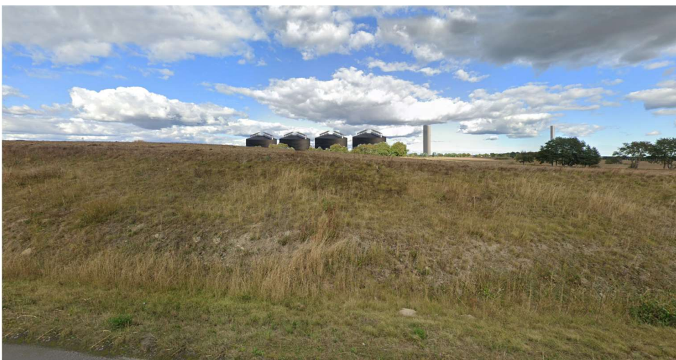
Figur 14. Vy från väg 11 i söder mot norr. Här går väg 11 i skärning, och vägens slänter minskar anläggningens exponering. WSP 2023.
