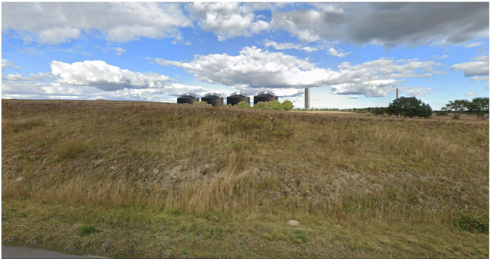
Figur 20. Vy från väg 11, mot norr. WSP 2023.
